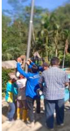
Gambar 6. Proses Pemasangan Lampu Penerangan Sel Surya oleh warga dan mahasiswa
