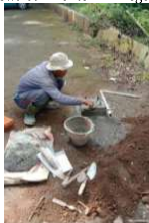
Gambar 5. Proses Pembuatan Pondasi untuk Peletakan Lampu Penerangan Sel Surya
