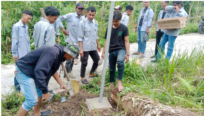
Gambar 4 Pemasangan Lampu Jalan Berbasis Tenaga Surya
