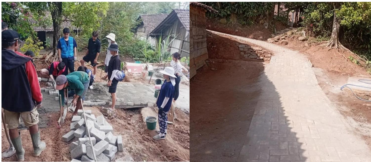
(a) (b) Gambar 6. (a) Pengerjaan Pemasangan Paving blok untuk jalur menuju TPQ (b) result
