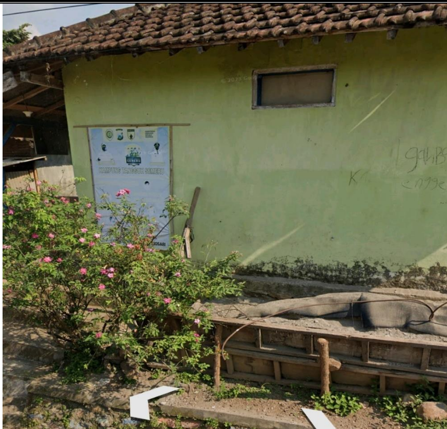
Gambar 4. Mushollah Al- ikhlas yang tidak mempunya tempat wudhu
