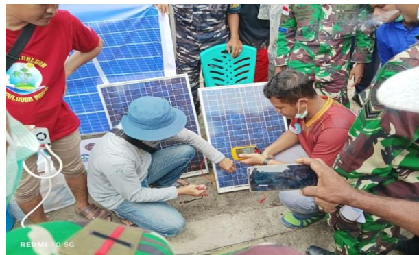
Gambar 9. Mengukur arus pada panel solar sell menggunakan multimeter digital
