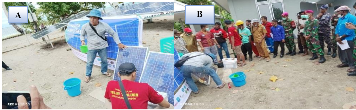
Gambar 6a. Pembersihan papan panel solar sel dan b. Mengeringkan papan panel solar sel
