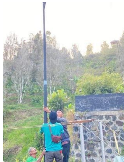
Gambar 3. Pemasangan PJUTS pada titik yang sudah ditentukan
