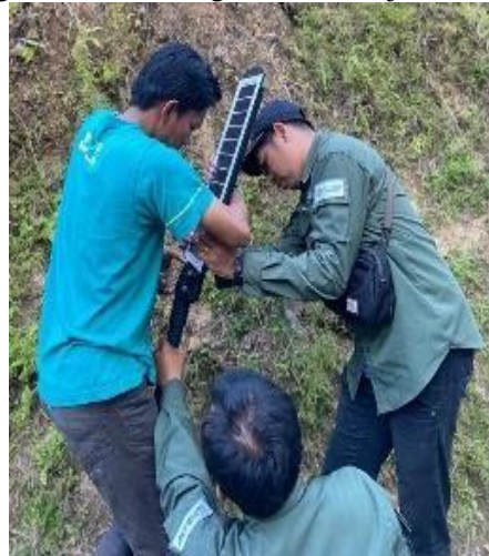
Gambar 2. Pemasangan Lampu Tenaga Surya Pada Tiang PJU
