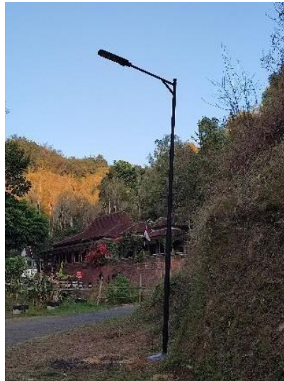
Gambar 4. Hasil pemasangan Penerangan Jalanan Umum Tenaga Surya (PJU-TS) di Dilem Wilis
