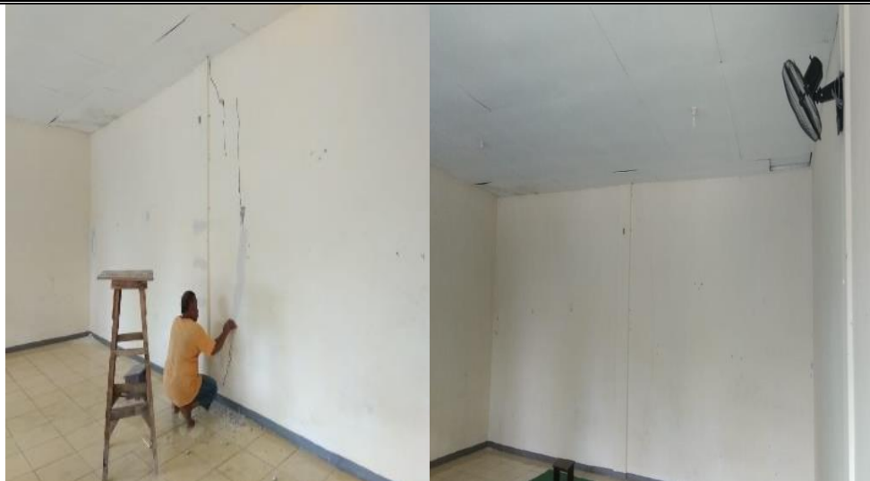
Gambar 4. Kondisi ruangan sebelum direnovasi
