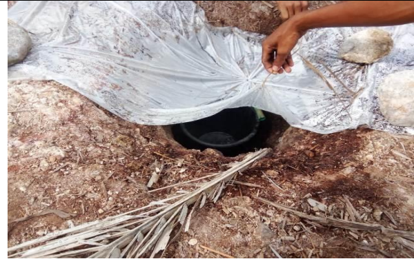
Gambar 3. Pembuatan media penangkapan uap air panas melalui plastik bening yang dirancang berbentuk payung terbalik
