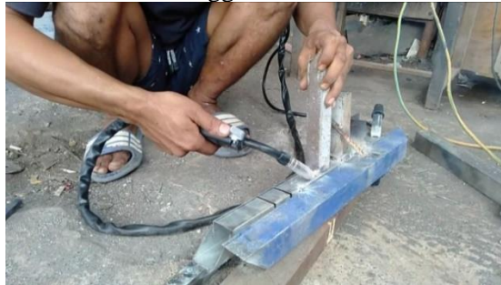
Gambar 4. Proses pengelasan menggunakan mesin Las MIG gasless
