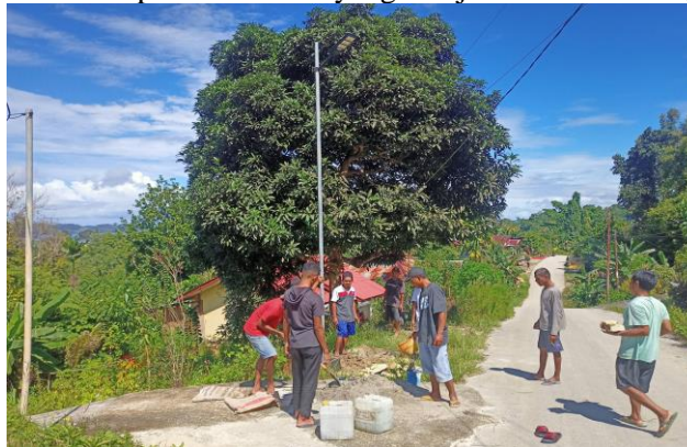
Gambar. 5. Pemasangan Lampu PJU Oleh Tim dan Warga
