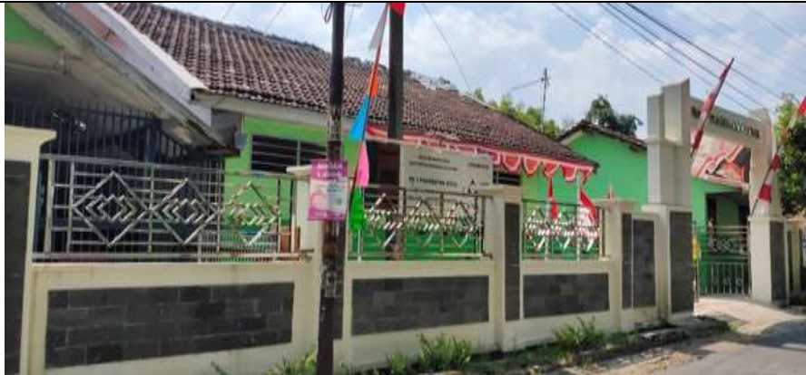
Gambar 2. Bangunan SD 1 Prambatan Kidul Kudus
