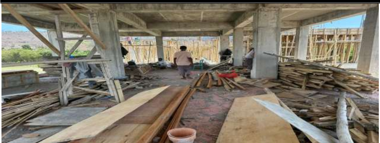
Gambar 2. limbah kayu, bambu, triplek hasil bongkaran bagisting per lantai Gedung II UM BIMA
