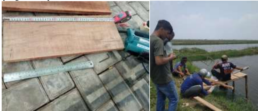
Gambar 3. Pembuatan dan Pemasangan Jembatan untuk Dudukan Alat Pakan
