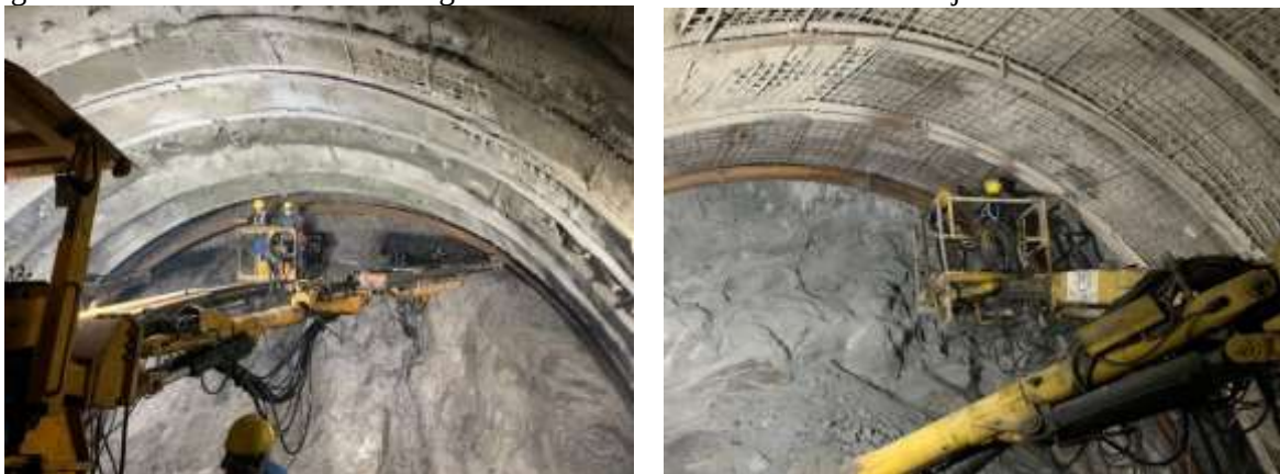
Gambar 6. Erection/Pemasangan Baja Steelrib, Pemasangan Wiremesh
