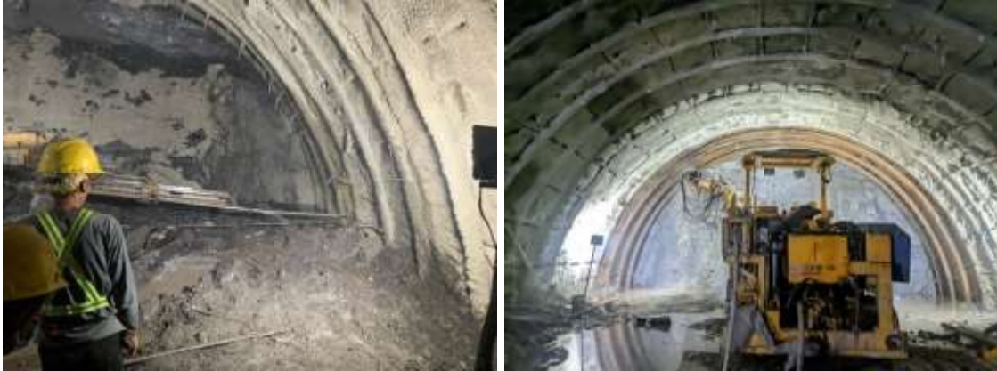
Gambar 8. (a) Pengeboran Rockbolt; (b) Pengeboran Forepoling/Pipe Roof
