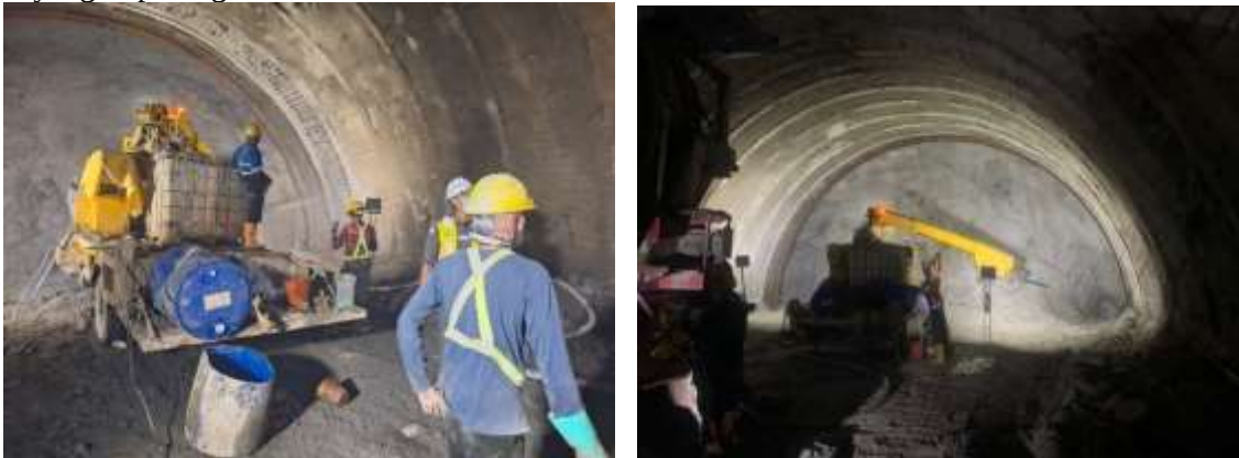
Gambar 7. Pekerjaan Shotcrete
