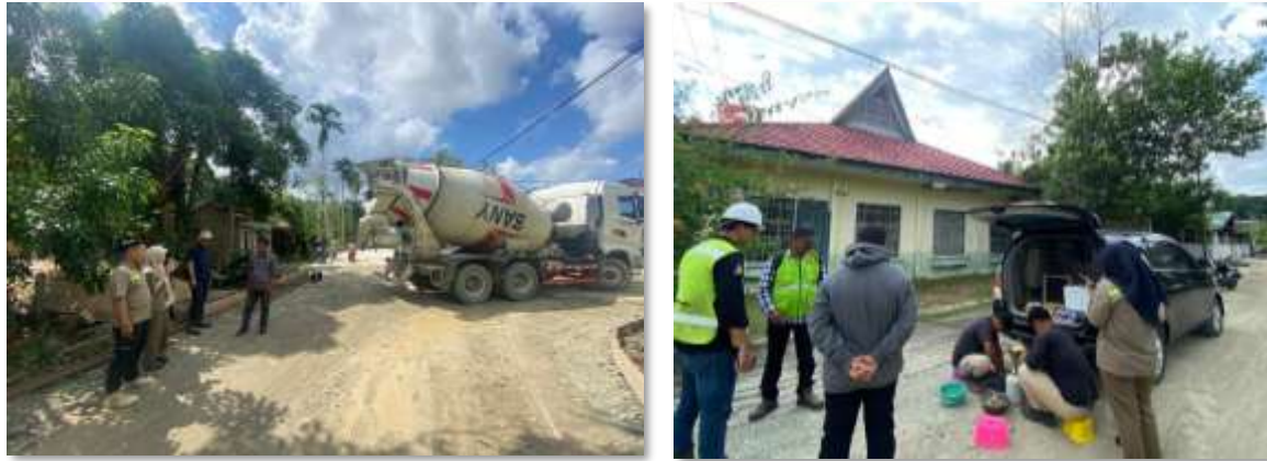
Gambar 3. Tahapan Kegiatan PKL di Proyek Pelebaran Jalan Taman Ulin
