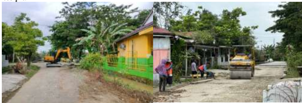
Gambar 6. Perkerjaan Berbutir Proyek Pelebaran Jalan Taman Ulin
