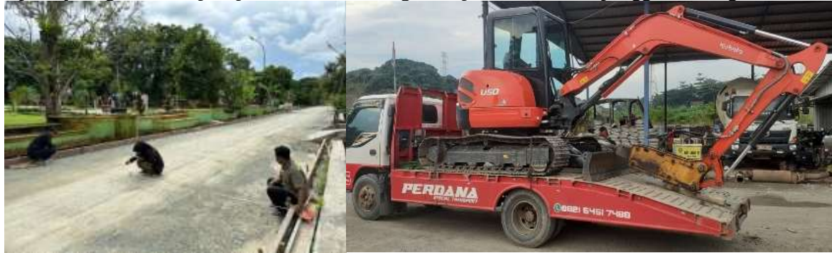
Gambar 4. Perkerjaan Persiapan Proyek Pelebaran Jalan Taman Ulin
