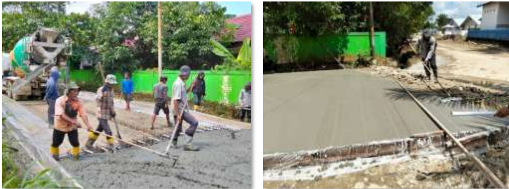
Gambar 7. Pekerjaan Perkerasan Beton Proyek Pelebaran Jalan Taman Ulin
