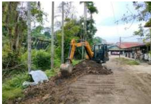
Gambar 5. Perkerjaan Tanah Proyek Pelebaran Jalan Taman Ulin
