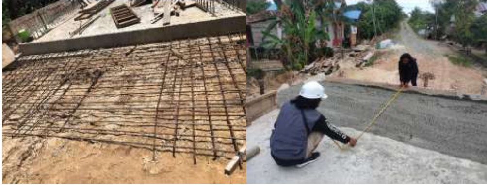
Gambar 10. Pekerjaan Pengecoran Plat Injak
