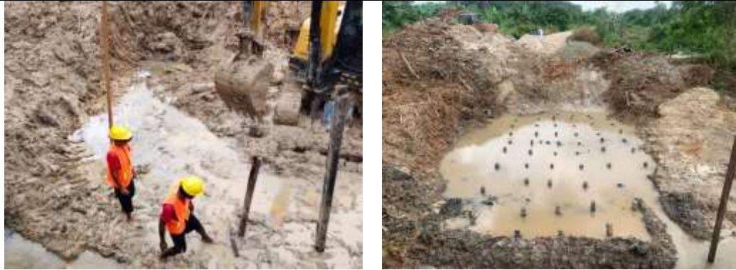
Gambar 5. Pekerjaan Pemancangan Cerucuk Ulin 10/10
