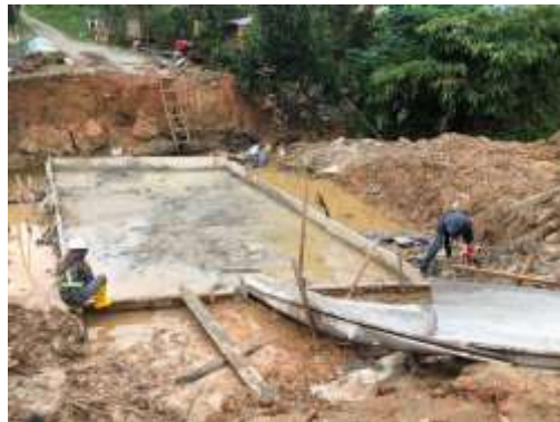
Gambar 6. Pekerjaan Pengecoran Lantai Kerja
