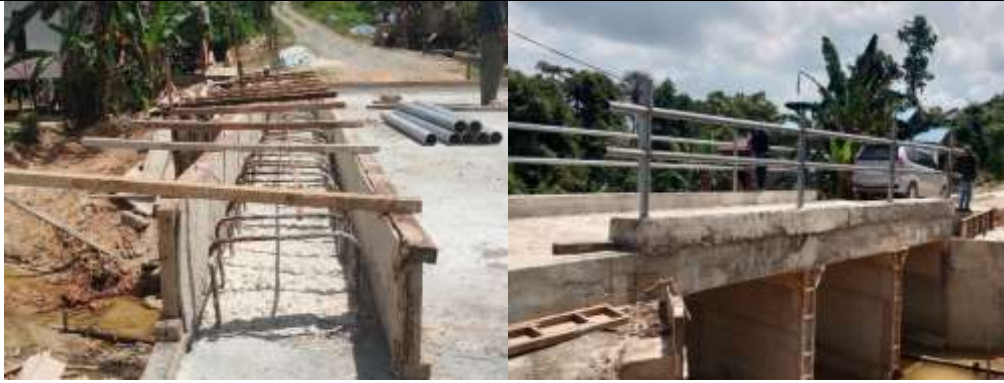
Gambar 12. Pekerjaan Pengecoran Kerb dan Pemasangan Railing
