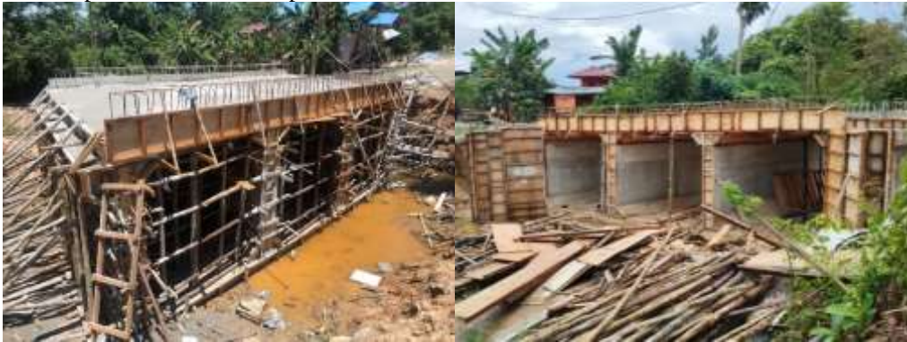
Gambar 8. Pekerjaan Pengecoran Box Culvert
