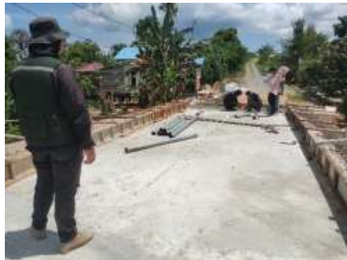
Gambar 11. Pekerjaan Perkerasan Beton Semen
