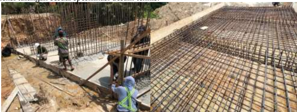
Gambar 7. Pekerjaan Pembesian
