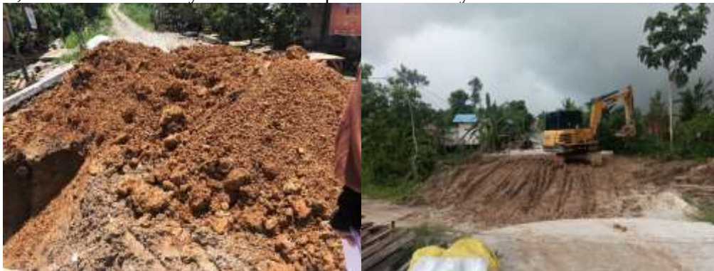
Gambar 9. Pekerjaan Penimbunan Tanah
