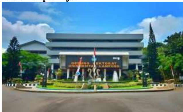
Gambar 9. Gedung Rektorat Universitas Lampung
