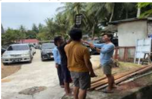
Gambar 1. Proses pemasangan PJU-1
