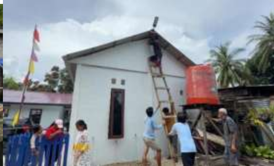
Gambar 2. Proses pemasangan PJU-2
