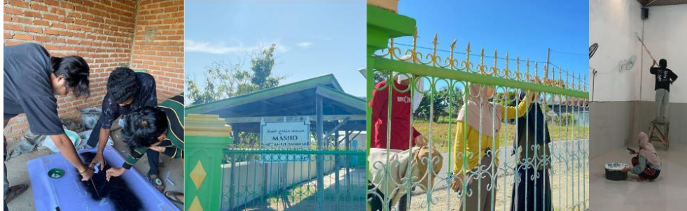
Gambar 5. Dokumentasi pengecatan masjid dan pemasangan papan nama baru (Sumber: Dokumentasi KKN, 2024)
