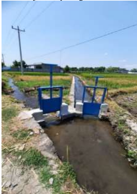
Gambar 5. Sistem irigasi sudah dilengkapi pintu air (Sumber: Tim Penulis, 2024)
