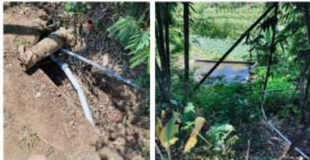
Gambar 4. Pemasangan Pipa dari Sumber Air ke Tempat Cadangan Air
