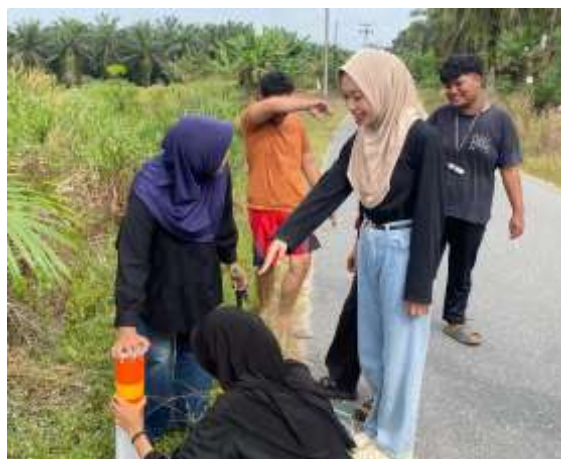
Gambar 3. Proses Pemasangan Reflektor
