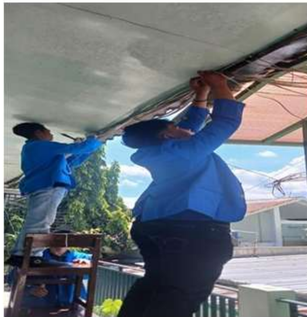
Gambar 3. Penarikan Kabel RJ45
