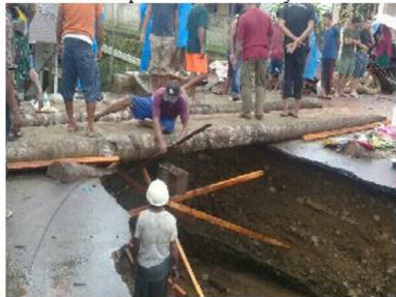
Jalan yang patah dan retak sekitar 2 meter
