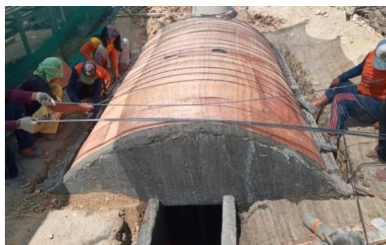
Gambar 7. Proses pembangunan instalasi
