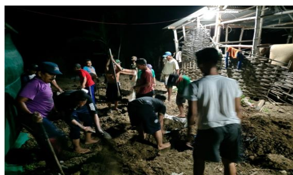
Gambar 5. Pembangunan instalasi Sumber: Dokumentasi Pribadi (2022)
