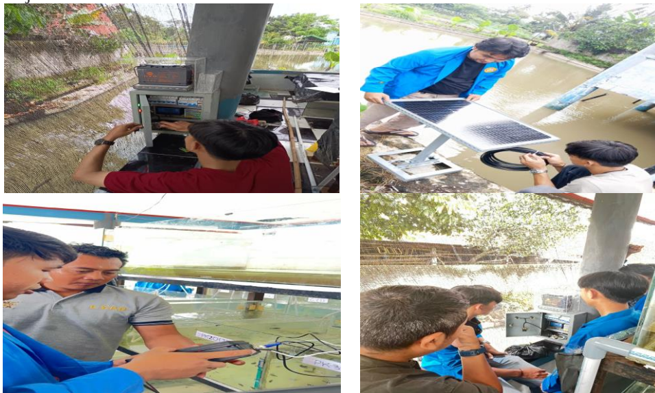
Gambar 6. Perakitan Komponen PLTS dan Sosialisasi Alat: (a) Perakitan Panel Power, (b) Pemasangan Solar Panel, (c) Sosialisasi Penggunaan Alat, (d) Sosialisasi Penggunaan Panel Power.
