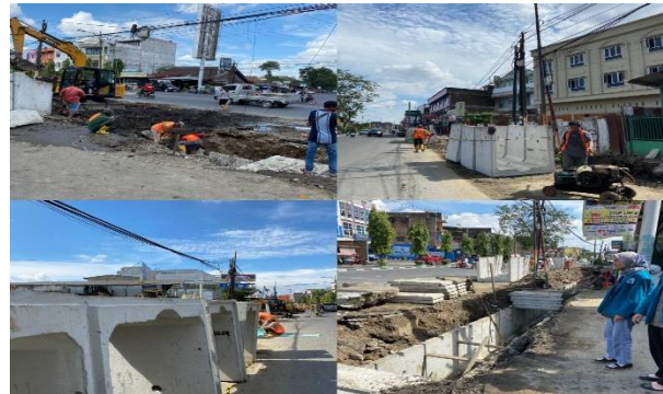
Gambar 6. Proses Pengerjaan Proyek Pembangunan Drainase
