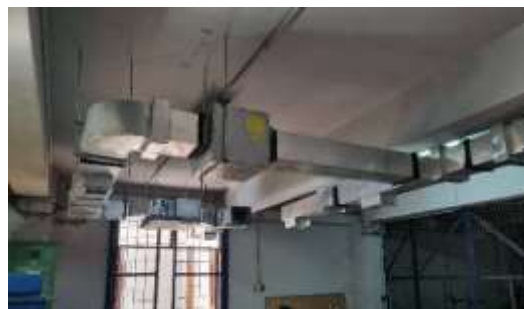
Gambar 1. Desain Square Ducting pada Air Handling Unit.
