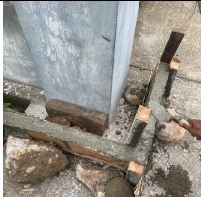
Gambar 7 Mahasiswa KKN-T Nganjuk 46 Membuat Pondasi Bagian Bawah Gapura
