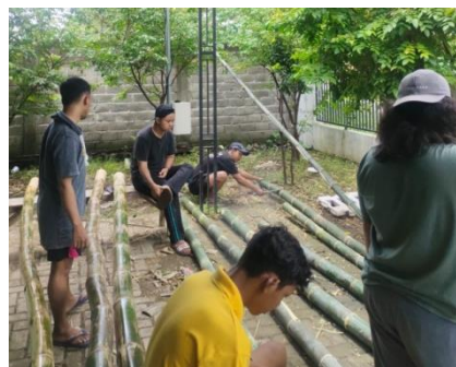
Gambar 6 Mahasiswa KKN-T Nganjuk 46 Membersihkan, Mengeringkan dan Memberikan Melamin pada Bambu
