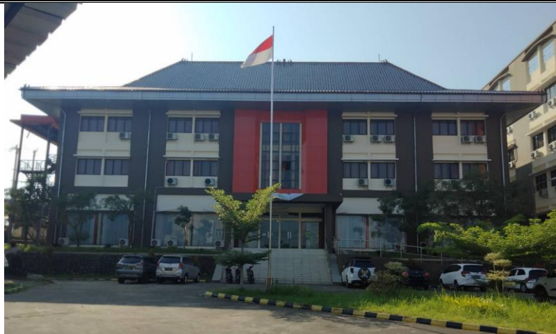
Gambar 2. Foto Lokasi Gedung Program Studi D4 Manajemen Informatika
