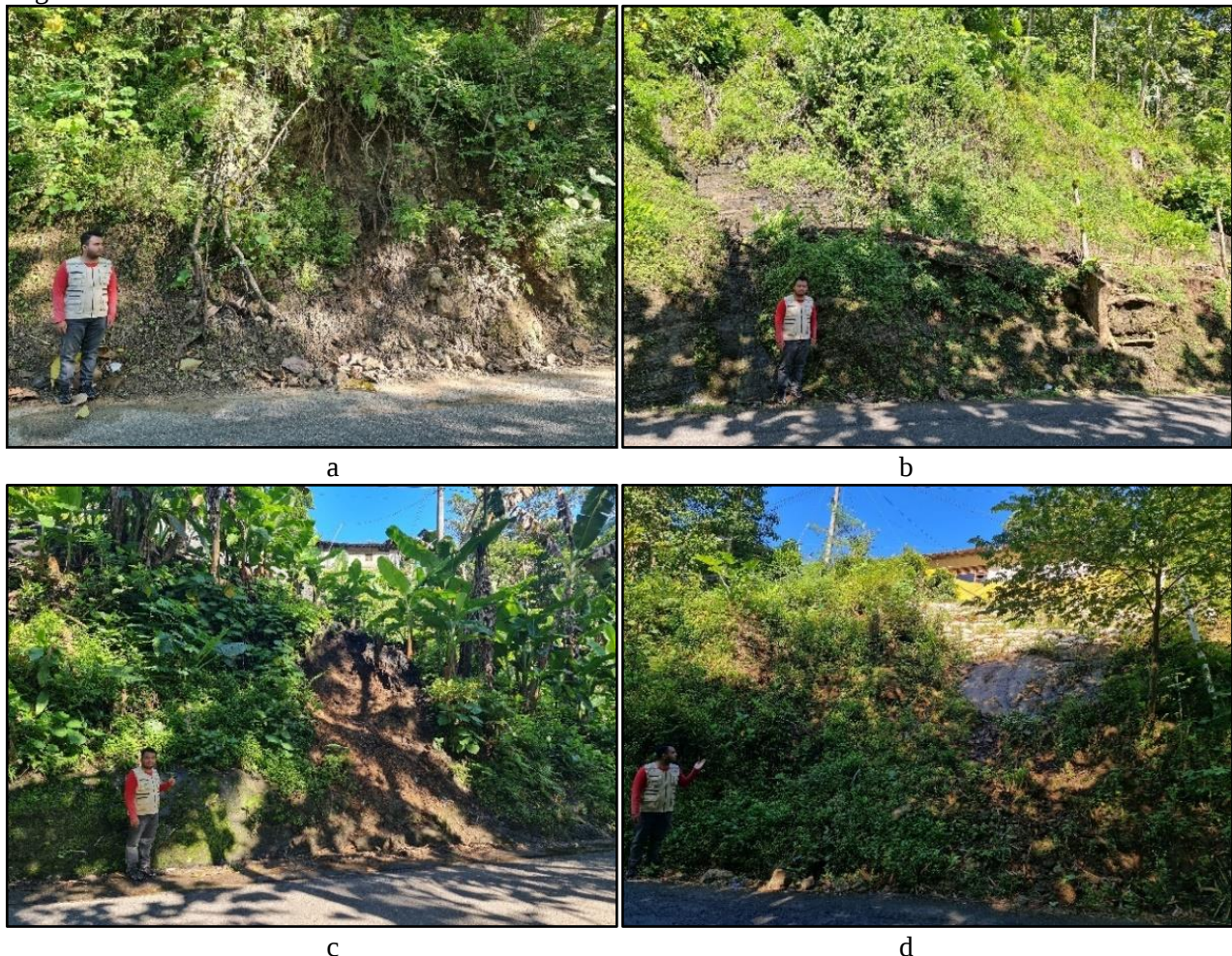
Gambar 2. a. titik kejadian bencana longsor 1, b. titik kejadian bencana longsor 2, c. titik kejadian bencana longsor 3, dan d. titik kejadian bencana longsor 4
