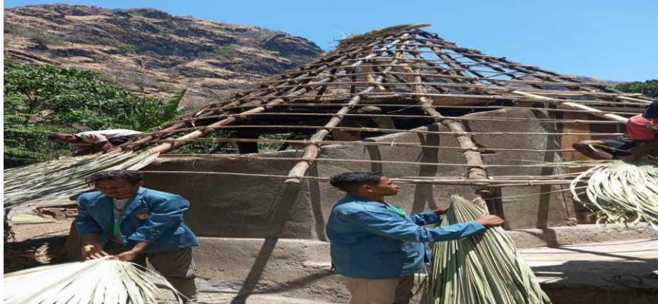
Gambar 4. Pengerjaan Menata Daun dan mengikatnya pada kerangka atap rumah adat.
