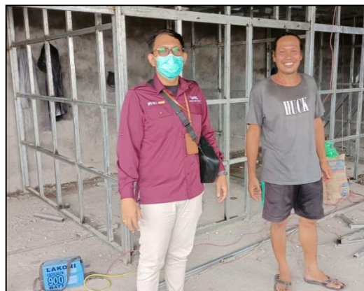
Gambar 2. Proses Pembuatan Rangka Kamar
