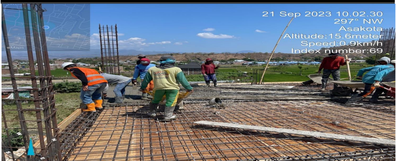
Gambar 6: Pendampingan Pengawasan pengecoran plat lantai mutu beton K275 Gedung II Universitas Muhammadiyah Bima
