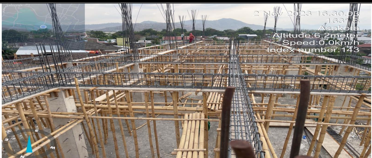
Gambar 3: Pembesian balok Gedung II Universitas Muhammadiyah Bima
