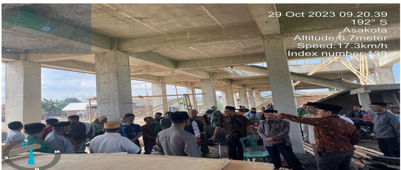
Gambar 4: Kunjungan Kerja PP Muhammadiyah ke Pembangunan kampus II Universitas Muhammadiyah Bima
