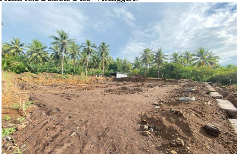
Gambar 4. Pembangunan bak penampung air hujan
