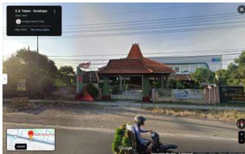
Gambar 1. Lokasi Balai Desa Plosowahyu
