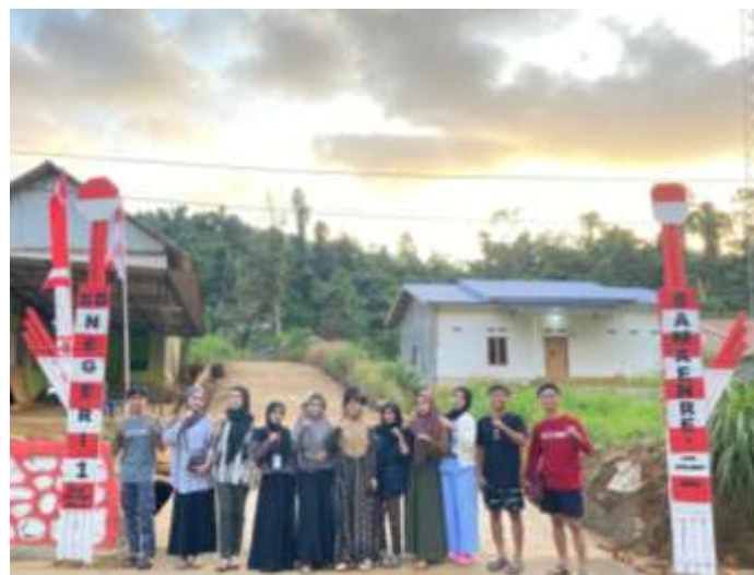
Gambar 3. Pemasangan Gapura di Jalan Masuk SDN 1 Samaenre
