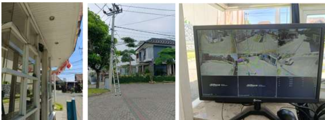
Gambar 3. Kondisi setelah pemasangan CCTV
