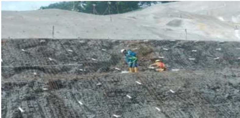
Gambar 7. Hasil Pemasangan Wiremesh
