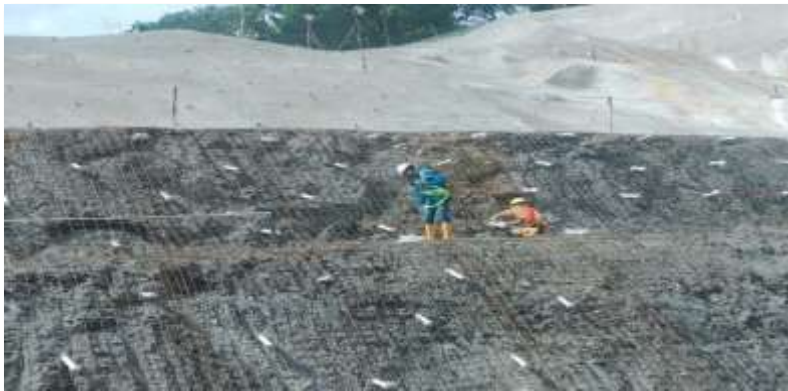
Gambar 7. Hasil Pemasangan Wiremesh
