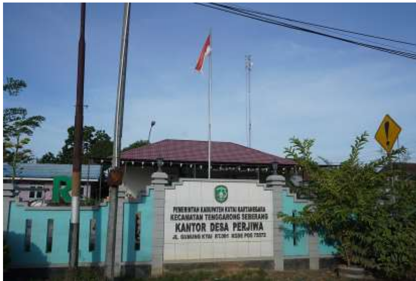
Gambar 1 Lokasi Kantor Desa Perjiwa
