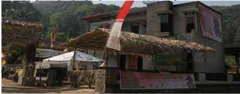
Gambar 1. Kantor Desa Citengah, Kabupaten Sumedang Selatan
