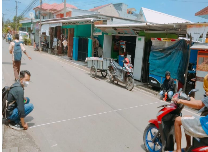
Gambar 3. Pengukuran Geometrik Ruas Sumber: dokumentasi pribadi, 2022
