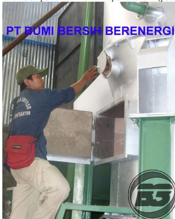
Gambar 3. Proses Instalasi Alat Gasifikasi Oleh PT. Bumi Bersih Berenergi.
