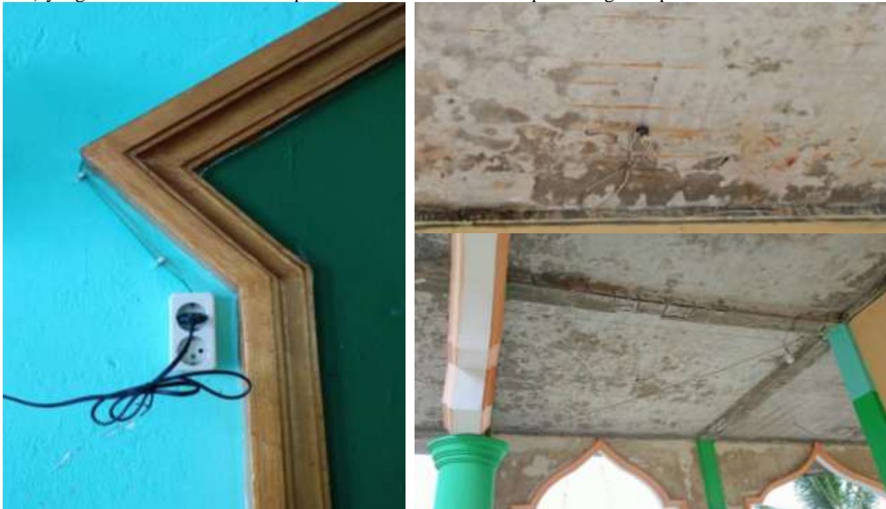
Gambar 2. Gambaran Instalasi Listrik di Masjid Al Barokah Kampung Kapaurtutin yang Belum Sesuai Standar PUIL
