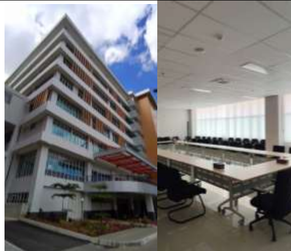
Gambar 1. Gedung Center of Excellence Universitas Pendidikan Indonesia
