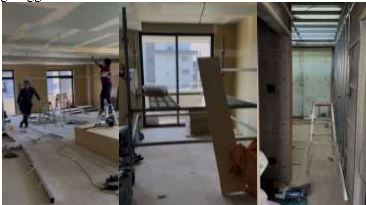
Gambar 1. Situasi Renovasi Pembangunan Masjid Indonesia Nagoya (MINA)
