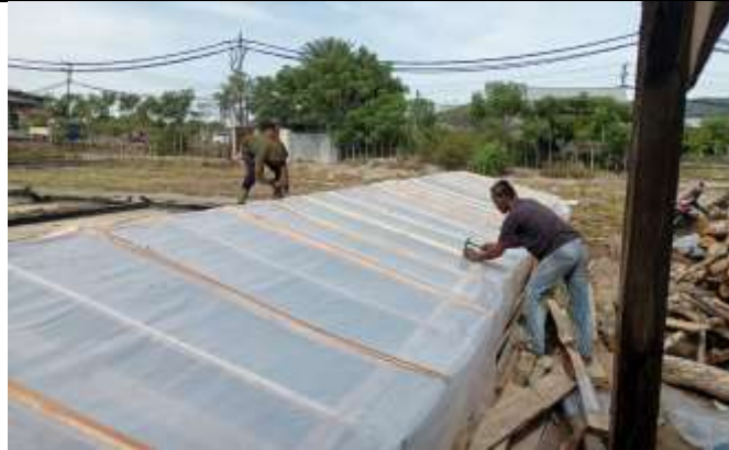
Gambar 3. Contoh konstruksi rumah tunnel
