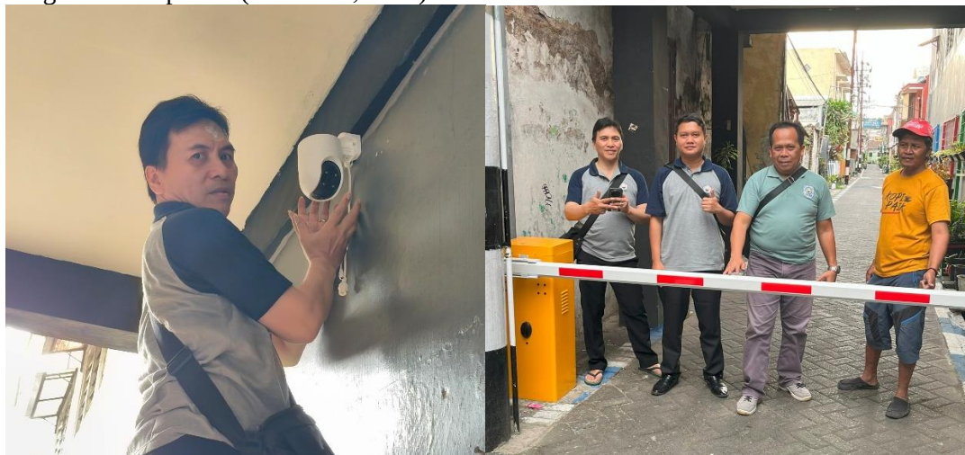
Gambar 4. Implementasi pemasangan barrier gate dan cctv pada titik utama jalan
