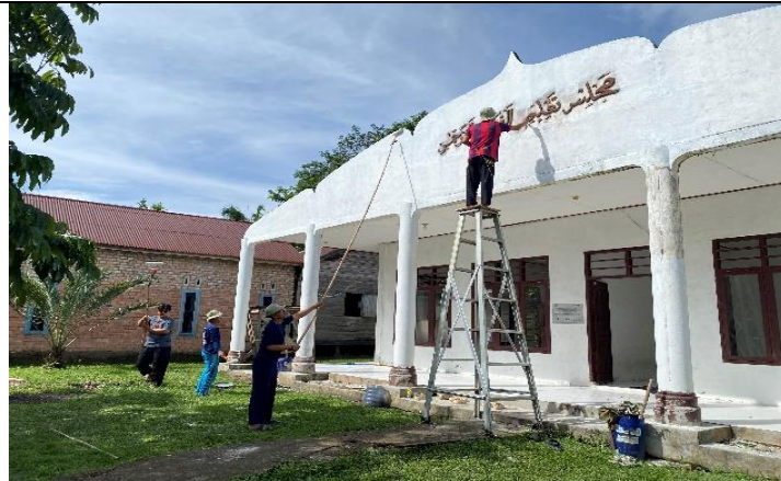
Gambar 1. Proses pengecatan Majelis Ta'lim di Desa Pematang Buluh.
