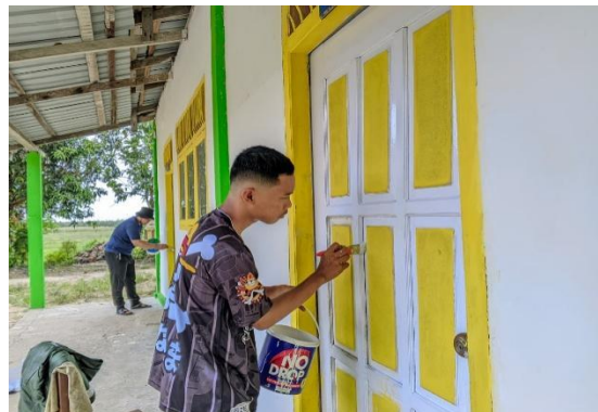
Gambar 2. Proses pengecatan Pagar Masjid di Desa Pematang Buluh
