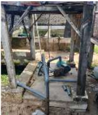
Gambar 1. Pembuatan Sumur bor
