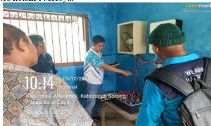
Gambar 4. Pengecekan komponen instalasi PLTS ke Pompa
